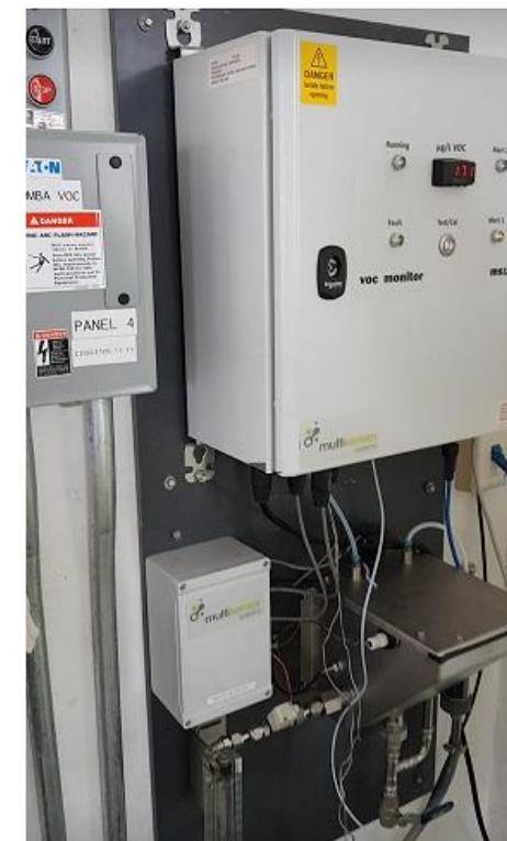
图为泵站安装的 MS1200。该装置通过 Profibus 协议（TCP/IP）连接到 SCADA 系统（以太网），该协议记录数据，并在发生事故时激活关闭吸入泵的警报。
