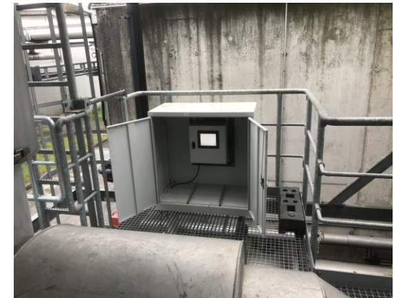
仪器安装在机柜中用于进一步防风雨的装置图片
